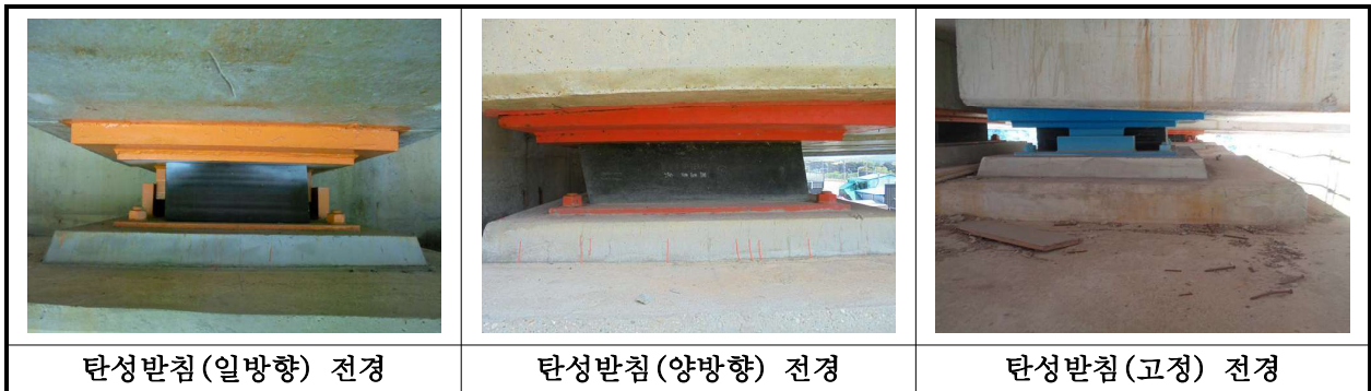
【사진 7.3.12】 교량받침 전경
