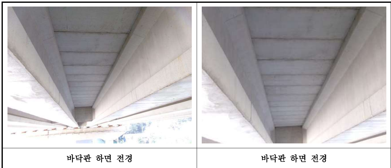
【사진 7.3.2】 바닥판하면 전경
