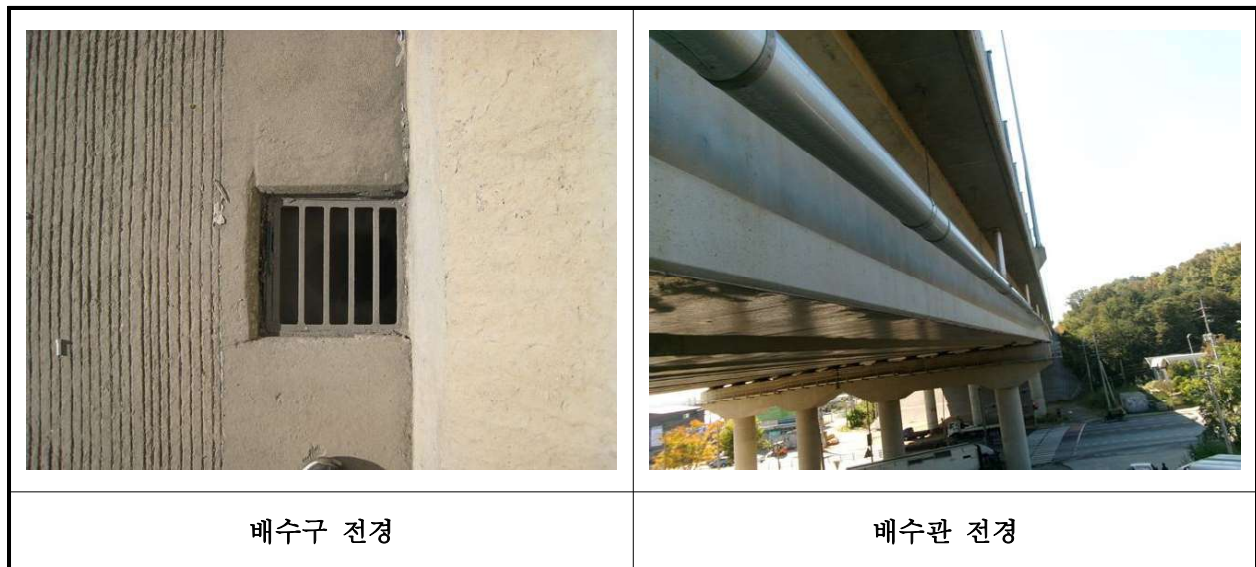
【사진 7.3.21】 배수시설 전경
