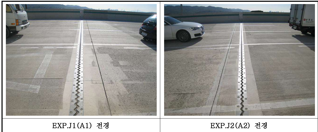
【사진 7.3.16】 신축이음장치 전경
