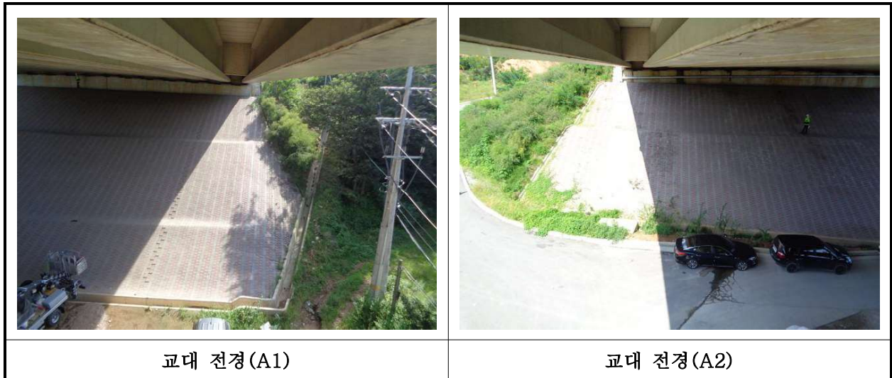
【사진 7.3.8】 교대 전경
