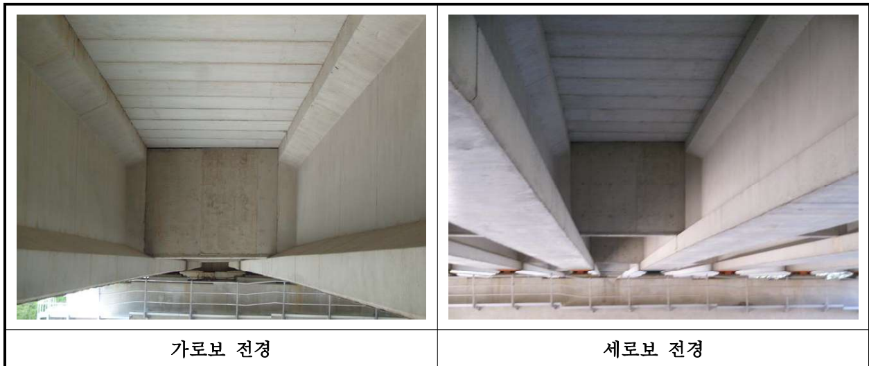
【사진 7.3.6】 가로보 및 세로보 전경
