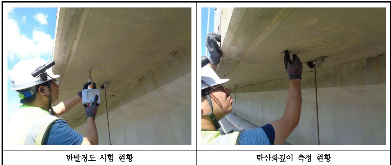
【사진 7.4.1】 콘크리트 내구성조사 현황
