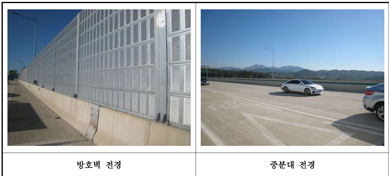
【사진 7.3.23】 방호벽 및 중앙분리대 전경
