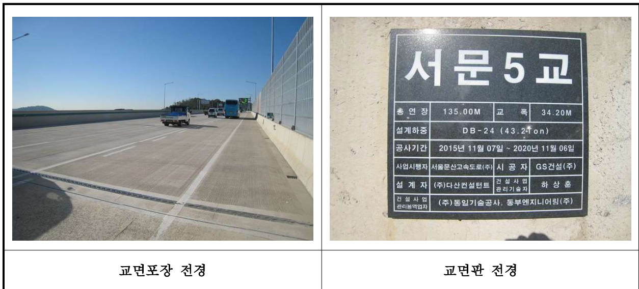
【사진 7.3.19】 교면포장 전경
